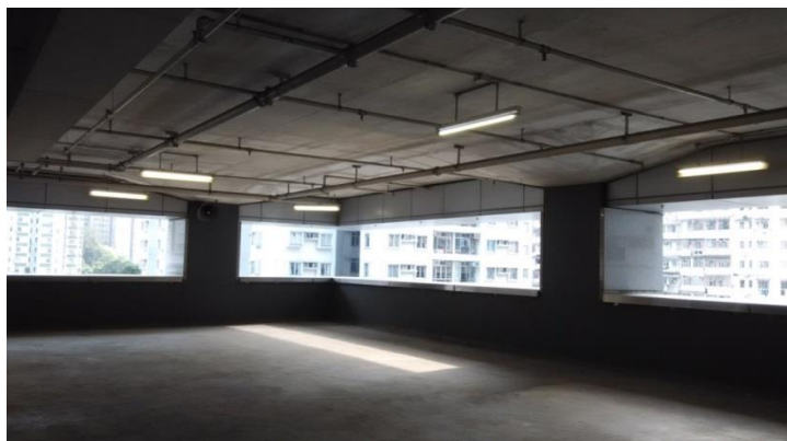
圖 12：隔火層安裝了 CET SmartDIM III 智能燈管
