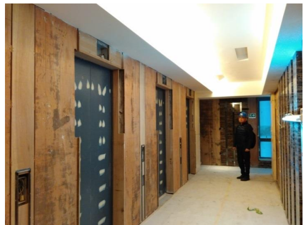
圖 10：電梯大堂安裝了 CET SmartDIM III 智能燈管
